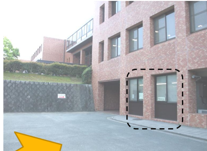
物品検収室設置場所
